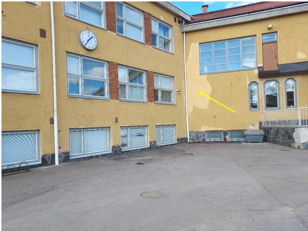
Kuva 4. Esimerkki näkyvästä laaja-alaisesta rappauskorjauksesta kaakkoissivulla.
