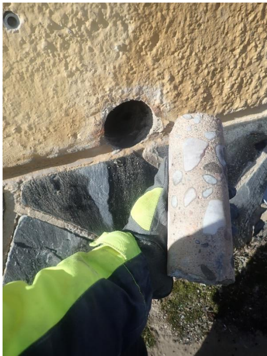
Kuva 1a, b ja c. Esimerkki alimman kerroksen kohdalle tehdystä rakenneavauksesta. Sokkelin luonnonkiviverhouksen yläpuolella yli 300 mm:n poraus ei vielä ulottunut sokkelin lämmöneristeseen saakka.
